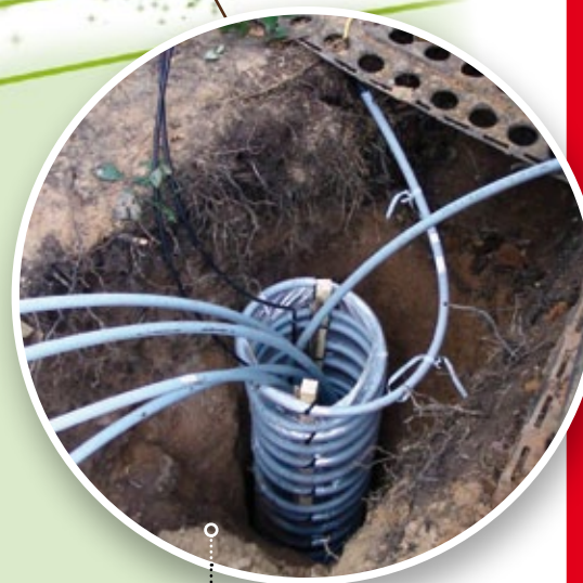
Mise en place des 3 corbeilles PEX 1-10m
