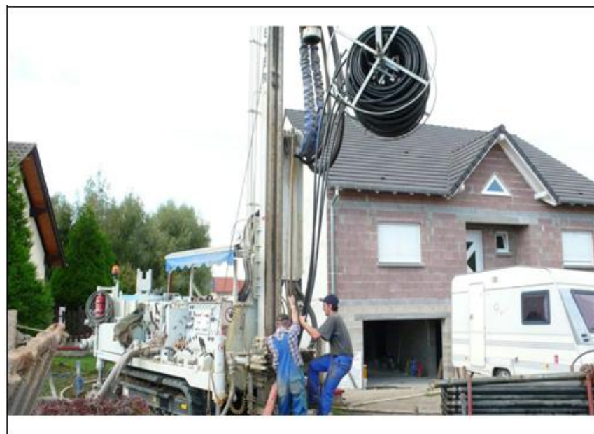
Mise en place de la sonde
