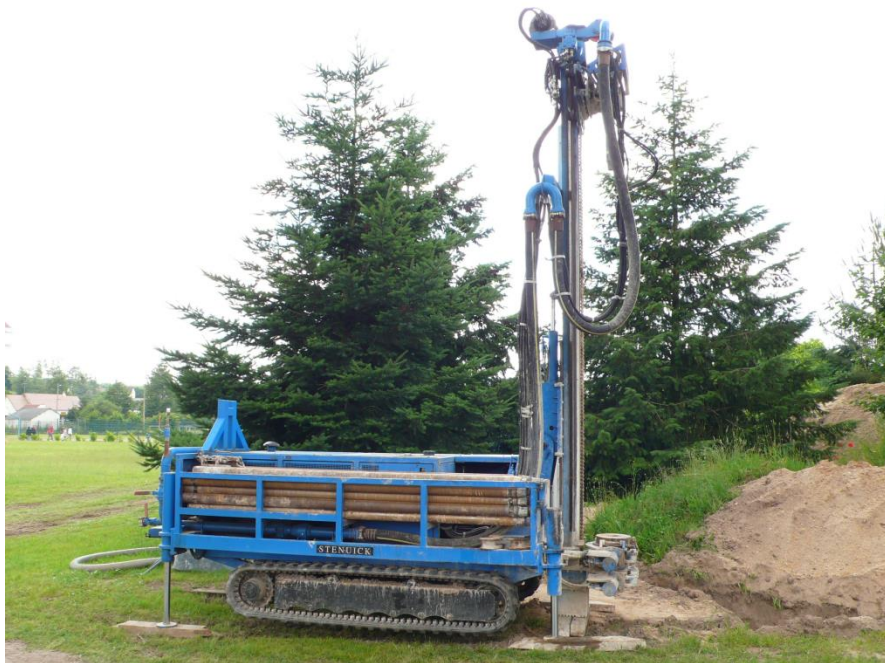
Machine de forage
