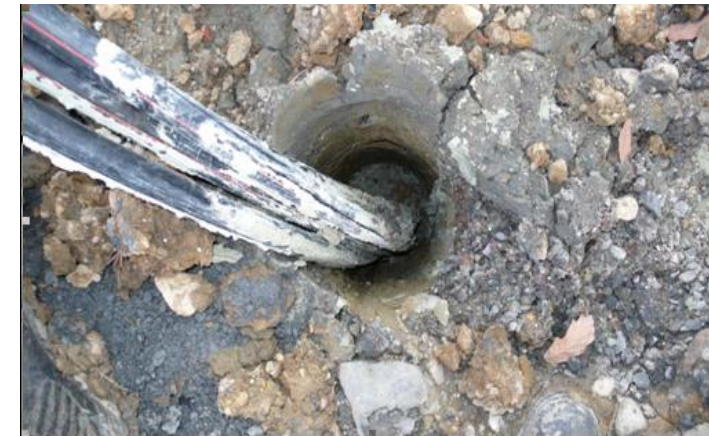
Mise en place de la sonde
